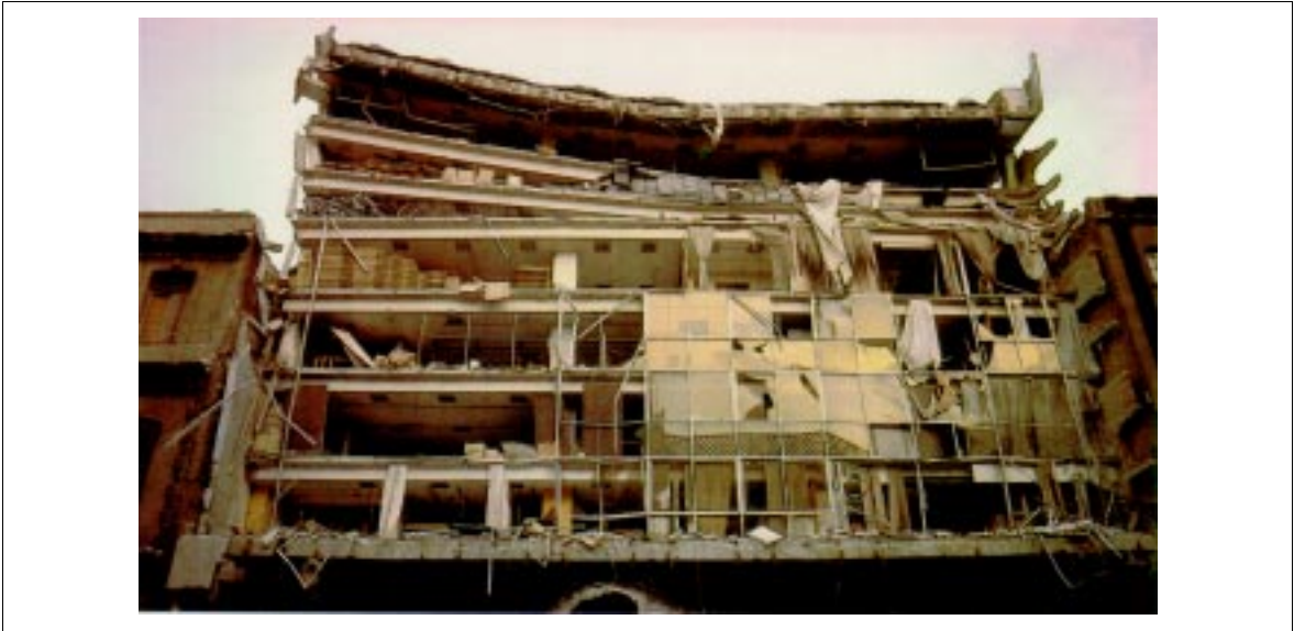
Abbildung 7: Schichtung der oberen Geschosse: Mexico City, Erdbeben 1985 [Münchener Rück, Seite 44, Dr. Berz, 1986]
