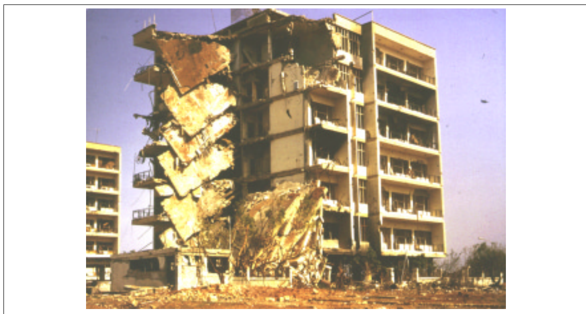
Abbildung 3: Schichtung im Vordergrund, hängende Rutschflächen hinten, Beirut, Kriegseinwirkungen 1982 [Hilberath, 1996]
