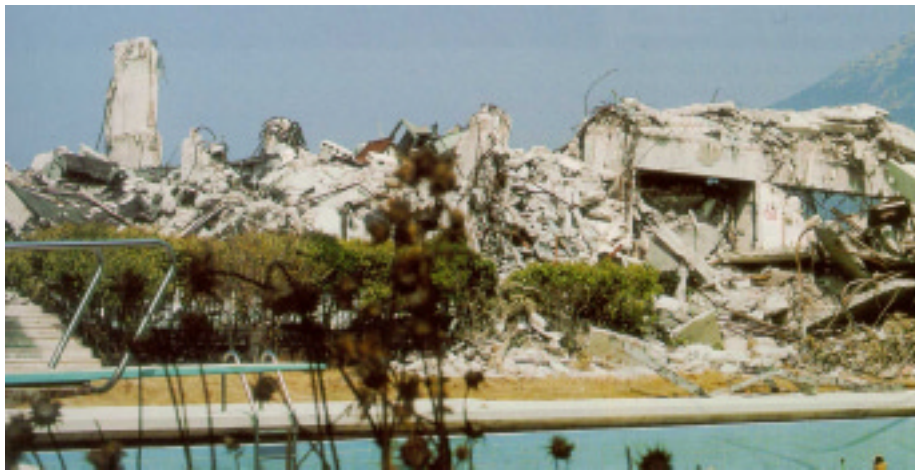
Abbildung 9: Großbrockiger Stahlbeton-Trümmerkegel, Griechenland, Erdbeben 1981 [Tiedemann, Seite 433, 1992]
