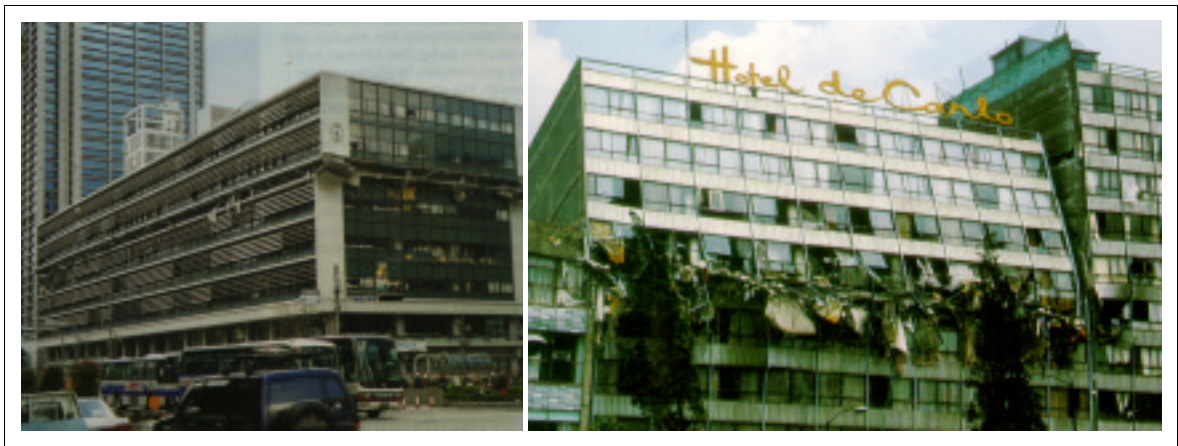
Abbildung 6: Schichtung im Mittelgeschoß: Kobe, Japan, Erdbeben 1995, [Münchener Rück, Seite 7, 1995] und Mexico City, Erdbeben 1985 [Tiedemann, Seite 443, 1992]
