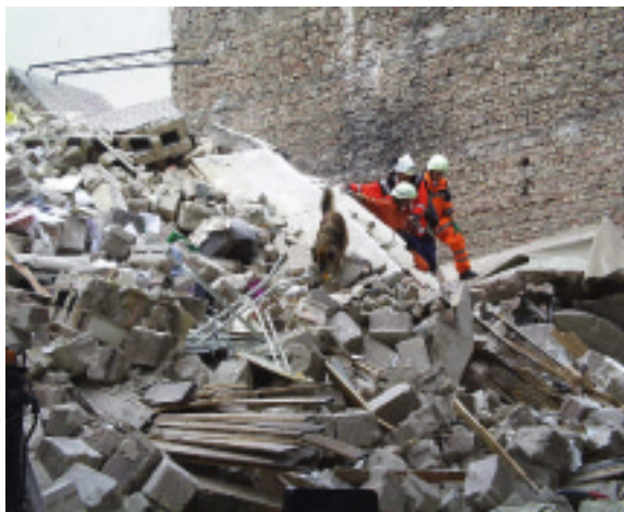
Abbildung 10: Großbrockiger Mauerwerks-Trümmerkegel, Berlin, Gasexplosion 1998 [Internet-Seite der Berufsfeuerwehr Berlin, 1998]
